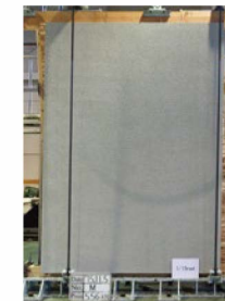
モルタル壁 (断熱材なし)
