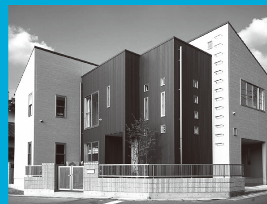
鉄骨縦張り工法
