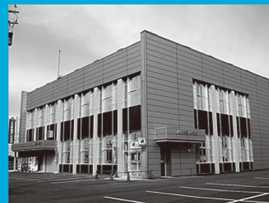
鉄骨横張り工法
